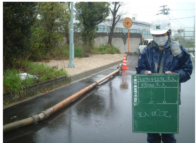
コンクリートポンプ車から注入口までの配管
