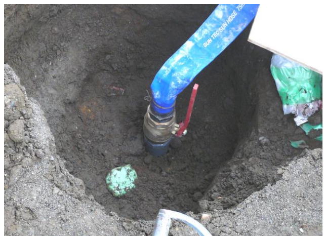
充填完了の確認 吐出口からの流出状況
