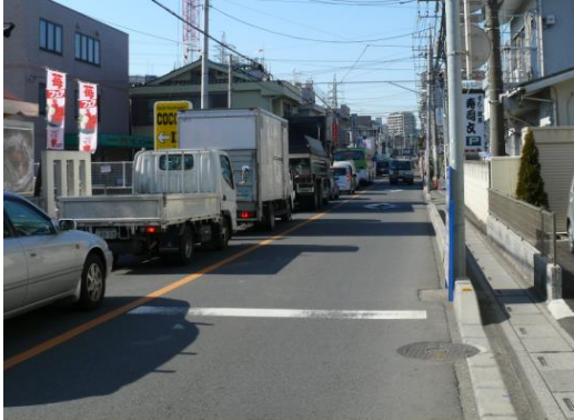
工事施工箇所の状況
