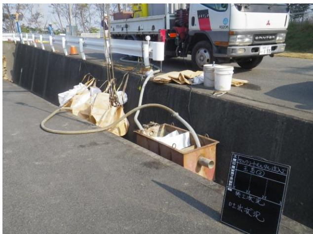
到達側設備設置状況(オイルマットを使用)
