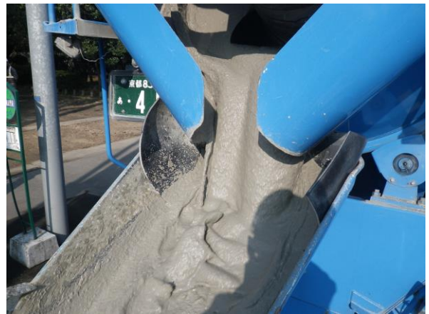
アジテーター車による運搬(注入口側)
