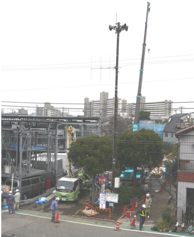
注入口設備 流量計及び注入管設置状況
