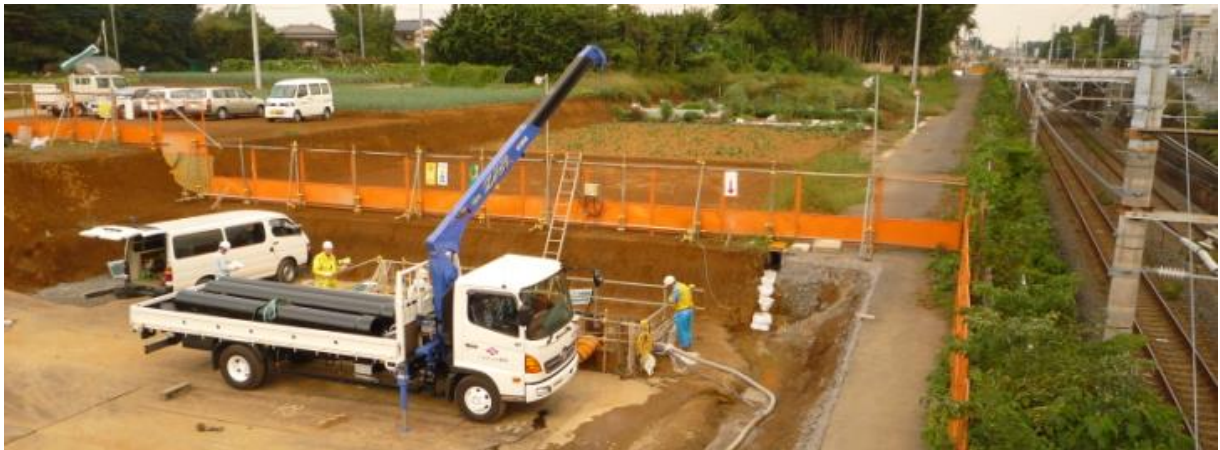
推進管発進立坑設備
