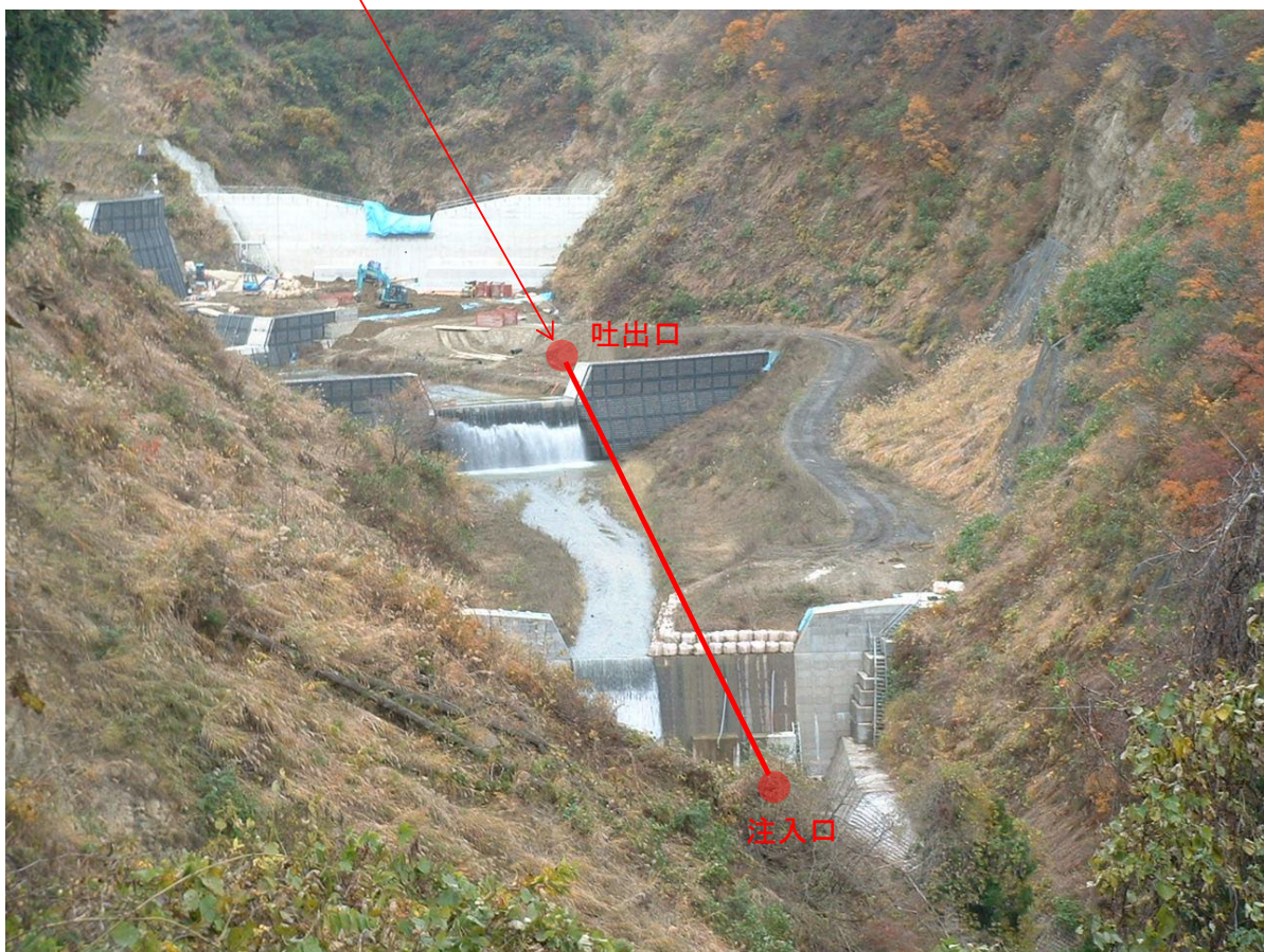
工事施工場所：セルクリート充填施工区間
