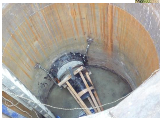
到達側吐出管設備設置状況
