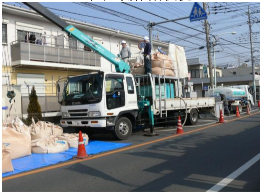
注入側作業状況
