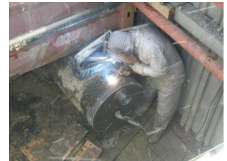
注入口加工状況
