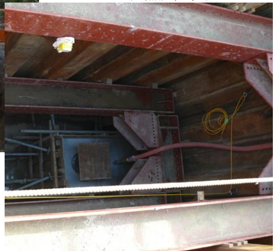
注入口設備設置状況
