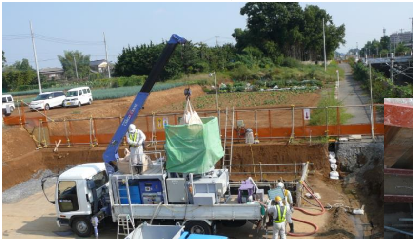
注入充填用車載式プラント設備設置状況(発進基地側)
