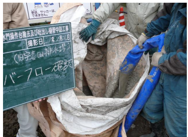
充填完了の確認 吐出口からの流出状況
