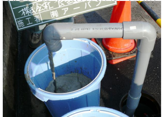
充填完了確認:管内滞留水排出後の充填材流出
