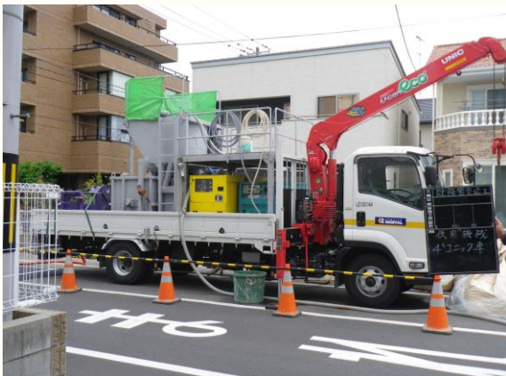
車上プラント攪拌・注入設備
