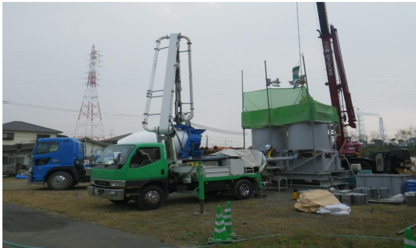
コンクリートポンプ車による注入設備
