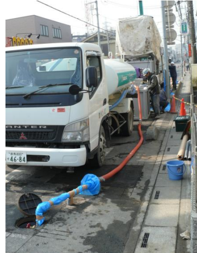
注入口(充填完了時)の状況
