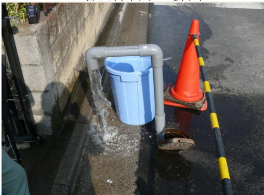
管内滞留水の排出
