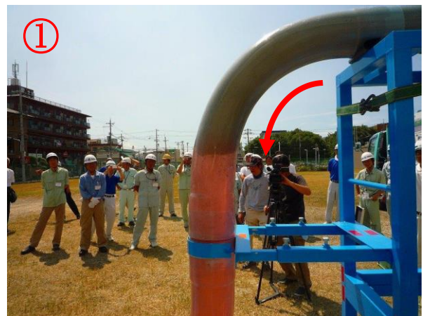
① 屈曲部の充填確認（下方向）
