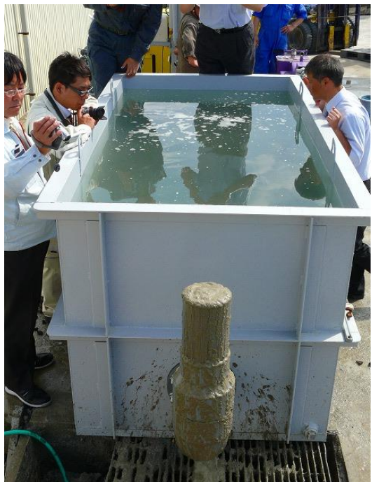
管内充填完了時の状況 吐出管からの充填材流出を確認水槽内は清水状態を保つ
