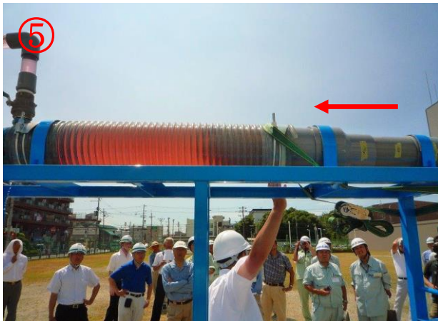
⑤ 伏越し後充填先端部
