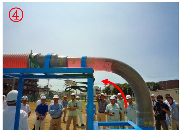
④ 屈曲部の充填確認（吐出側）
