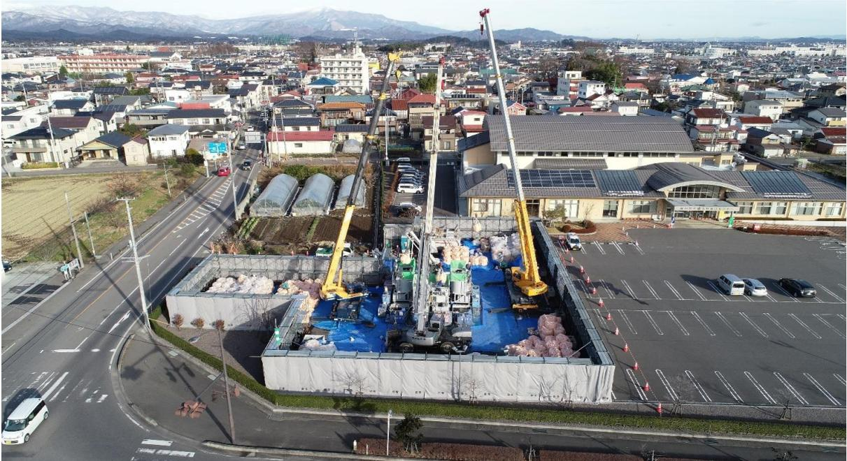
定置式プラントヤード(2連3組 充填材料 1区間分約500m<sup>3</sup>分納入)
