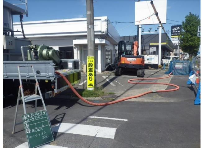
注入口①(推進鞘管空隙充填)
