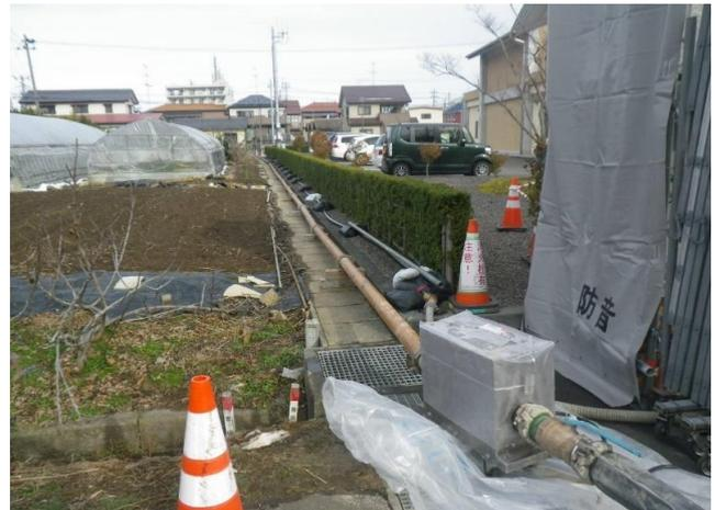
コンクリートポンプ車圧送管 約100m配管
