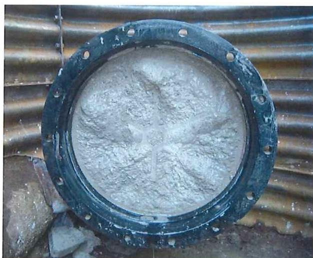
到達側端部閉塞型枠取外し後の状況（ $\phi 450\text{mm}$ ）
